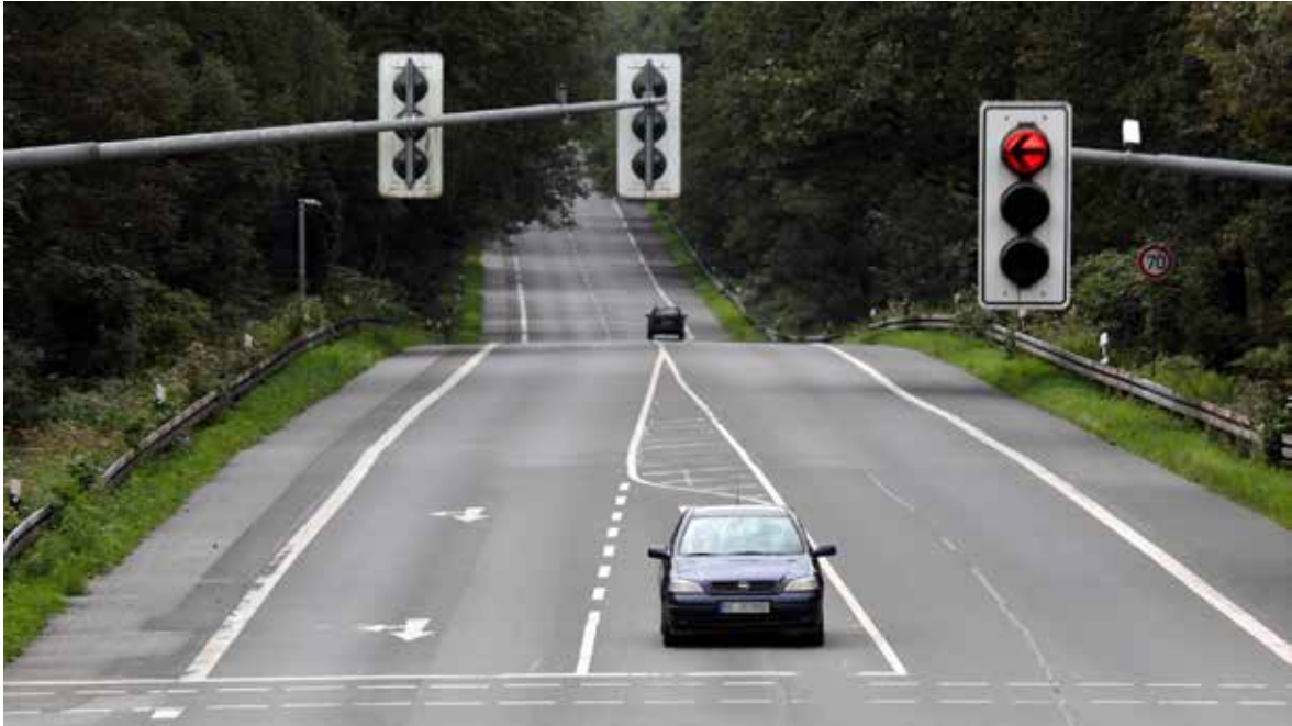
Abb. 8: Bergsenkungsmulde entlang der Münsterstraße in Gelsenkirchen. Im Vergleich zum Jahr 1892 hat sich das ursprünglich ebene Gelände um mindestens 19 m abgesenkt (eigene Aufnahme)
